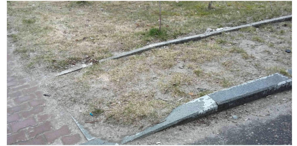
Вид на существующее покрытие
