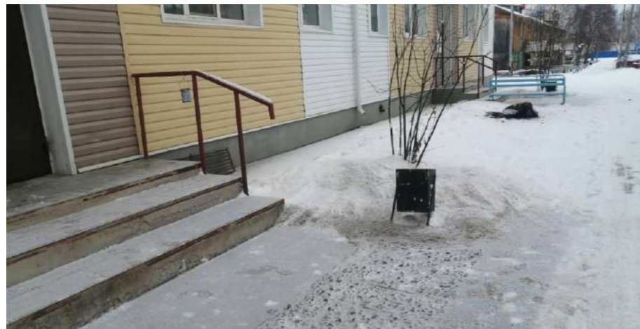
Вид на подъезды
