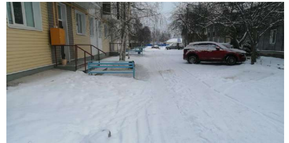
Вид на проезд вдоль многоквартирного дома
