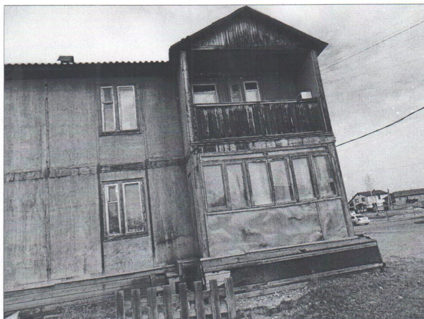
Фото №18. Фрагмент фасада
