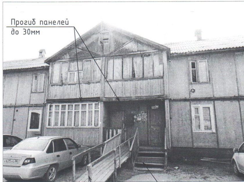
Фото №1. Фрагмент фасада
