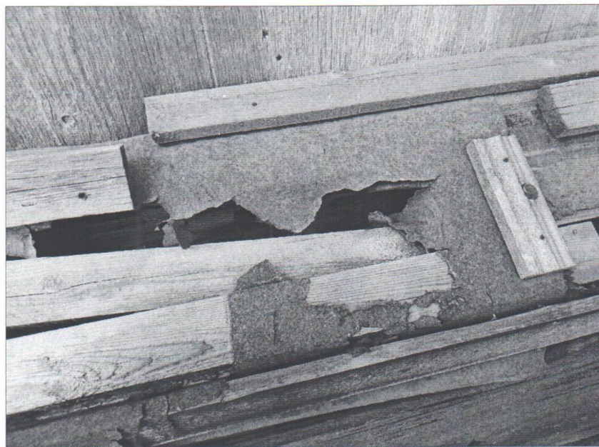
Фото №17. Фрагмент цокольной части
