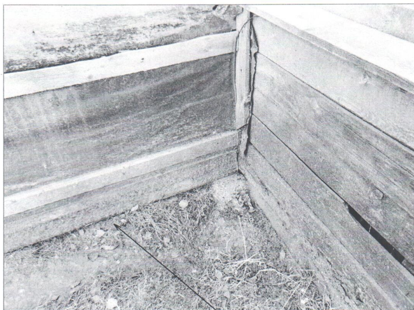
Фото №13. Фрагмент цокольной части
