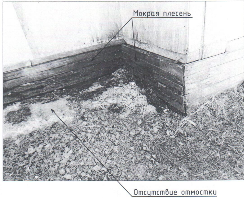
Фото №5. Фрагмент цокольной части
