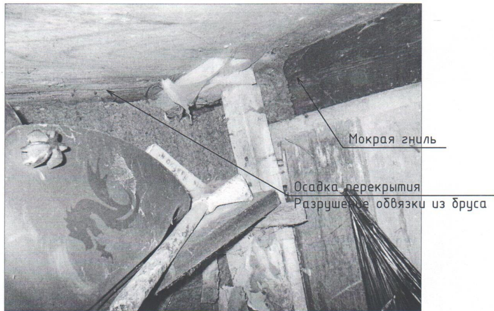
Фото №7. Фрагмент цокольного перекрытия
