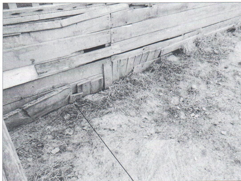
Фото №12. Фрагмент цокольной части
