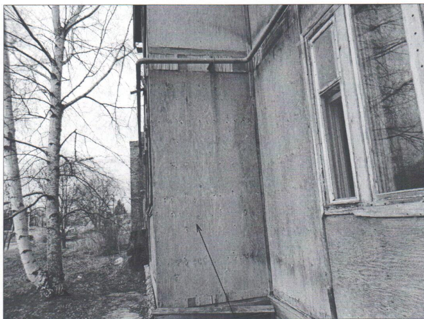
Фото №16. Фрагмент фасада
