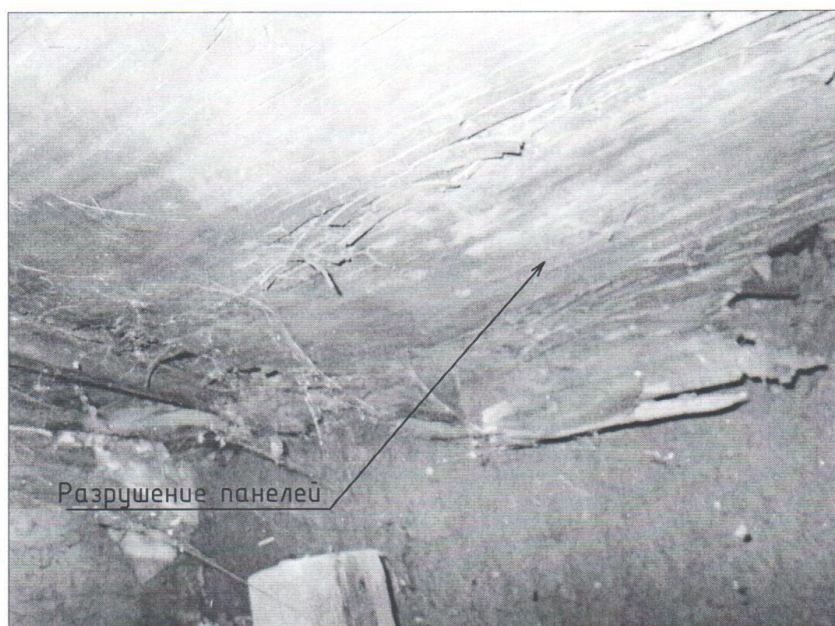
Фото №9. Фрагмент цокольного перекрытия
