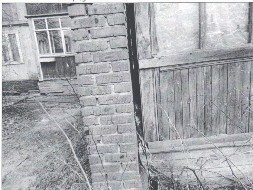
Фото №14. Фрагмент примыкания брандмауэрной стены к торцу дома
