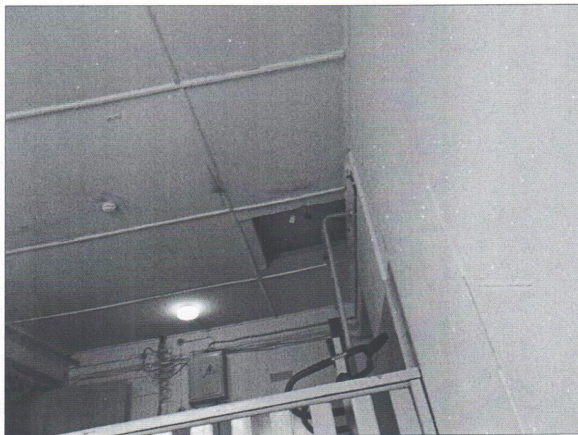
Фото №22. Фрагмент лестничной клетки
