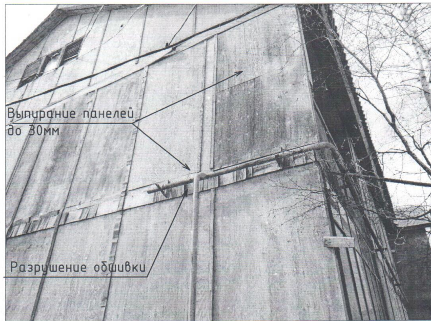
Фото №3. Фрагмент фасада
