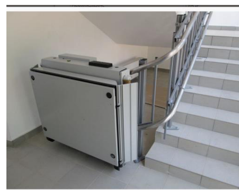
Рисунок 4.23 – Размещение подъемных платформ наклонного типа
