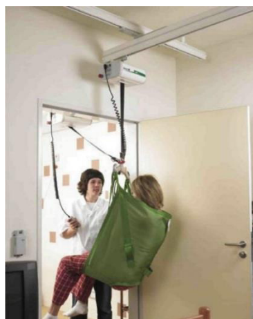
Рисунок 7.14 – Применение в санузлах подвесных устройств
