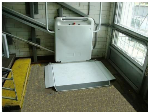
Рисунок 4.20 – Наклонная подъемная платформа перед лестницей с боковым въездом на нее
