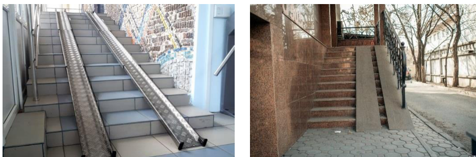
Рисунок 3.33 – Пандус аппаратль (не допустим к применению)
