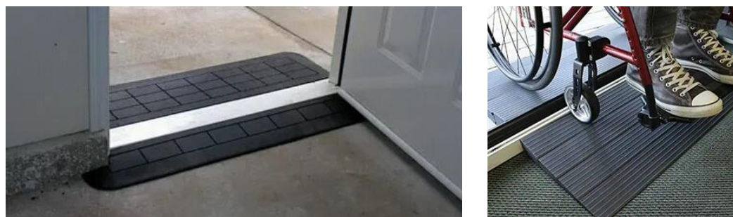
Рисунок 4.8 – Устройство мини-пандусов у порогов высотой более 0,014м
