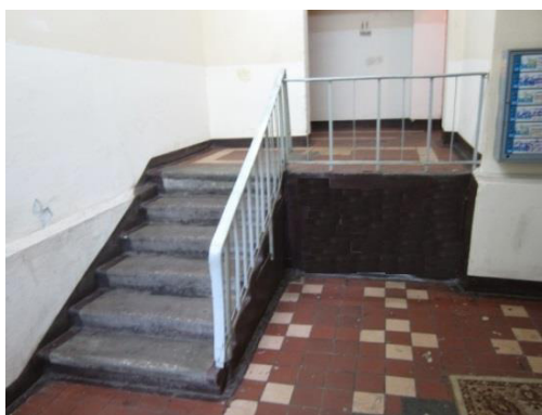
Рисунок 4.25 – Свободное пространство для установки подъемной платформы
