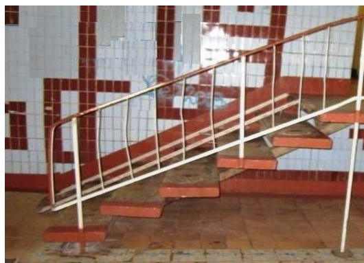
Рисунок 4.13 – Лестничные марши в вестибюле
