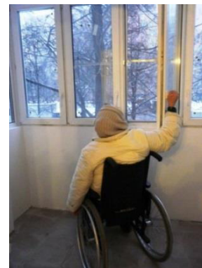
Низкое расположение оконной фурнитуры
