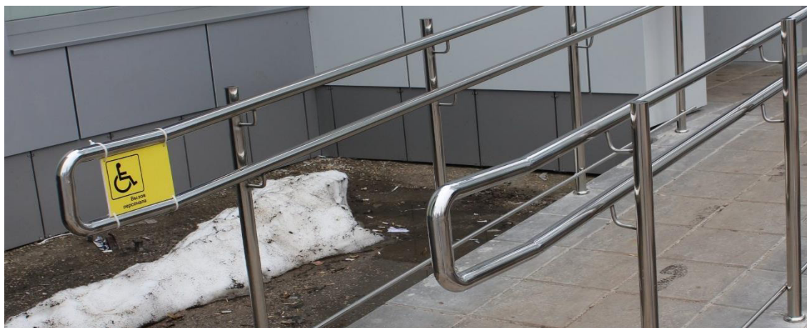
Рисунок 3.24 – Пандус с нормативной конструкцией поручней
