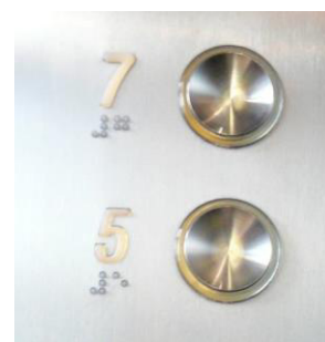
Рисунок 8.11 – Рельефные цифры на пульте управления лифта
