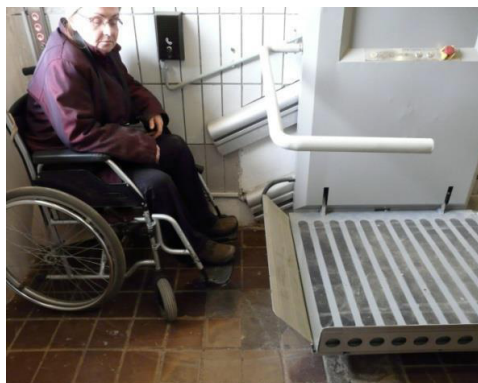
Рисунок 4.19 – Наклонная подъемная платформа перед лестницей с въездом на нее при прямом движении
