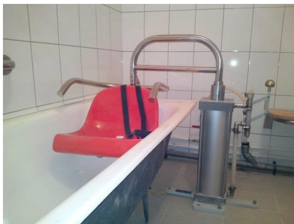
Рисунок 9.4 – Стационарный гидравлический подъемник для использования в ванной комнате
