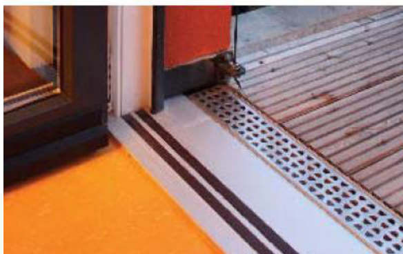
Рисунок 7.10 – Устройство на балконе фальшпола для уменьшения высоты порога
