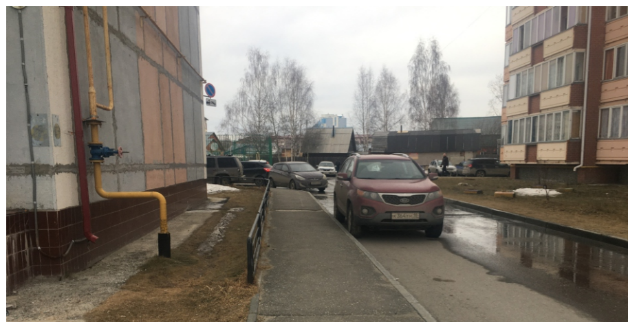
Вид на проезд с улицы Никольская
